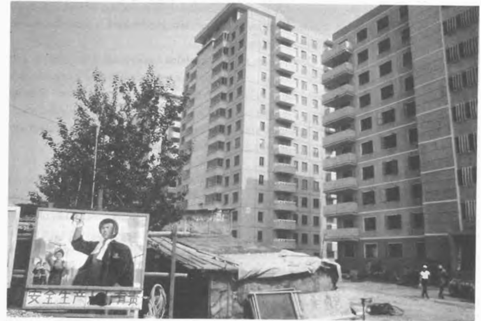
Die ersten Bauteile der »neuen Großen Mauer«: Fahrstühle bleiben stecken, Lichtschächte sind schief – viele Wohnungen blieben leer...
