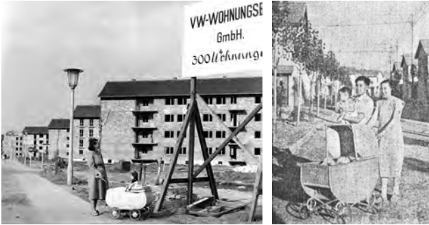
Abb. 3: Wohnungsbau Wolfsburg, Braunschweiger Straße (1954), Quelle: Institut für Zeitgeschichte und Stadtpräsentation (IZS) Wolfsburg.
