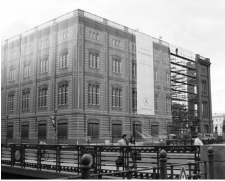
Abb. 8: 2004 stellte der „Verein Internationale Bauakademie Berlin e.V.“ eine gedruckte Schaufassade der Bauakademie (1832-1836) fertig. Mit der Reihung gleicher Konstruktionsachsen und den reproduzierbaren Bauplastiken hatte Karl Friedrich Schinkel einen rationalistischen Bau erschaffen, der als Gründungsbau der Moderne gilt und das Ideal von Material- und Konstruktionsgerechtigkeit symbolisiert.
