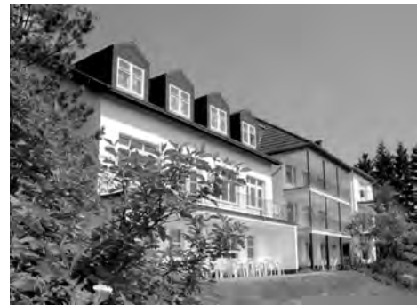
Abb. 6: Ehemaliges Kurhotel Herrenbusch; umfangreich modernisiert 2012/13; 1971 Bildungsstätte der Friedrich-Ebert-Stiftung; 1985 Kurt-Schumacher-Akademie; Foto: Friedrich-Ebert-Stiftung.
